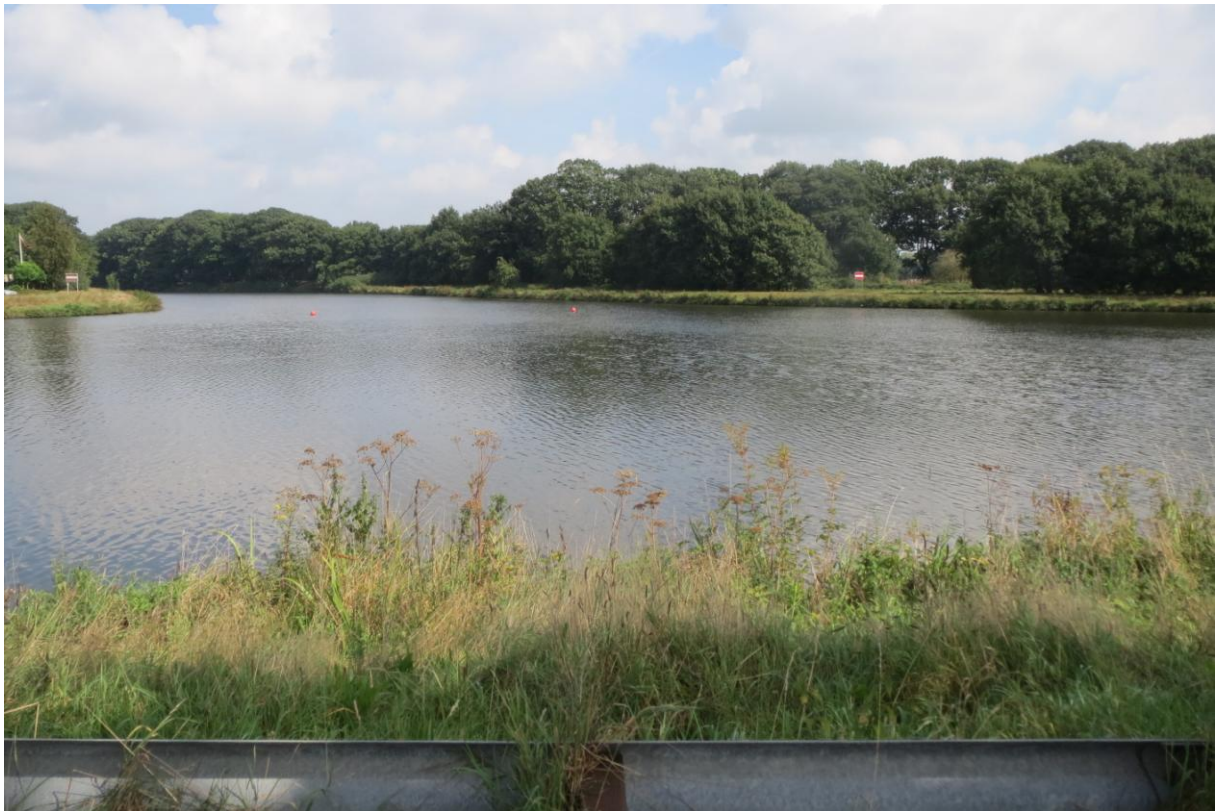
Het gat bij de Brandaris aan het Wilhelminkanaal in Oosterhout
